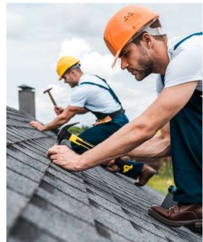
Zimmerei & Dachdeckerei sowie GWH-Installateur, Schweißer etc.
