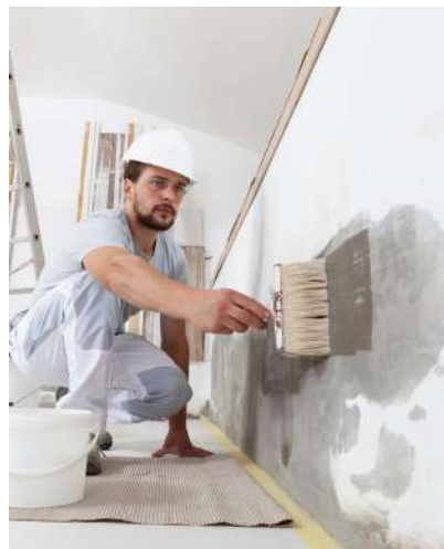
Maler & Anstreicher im Innen- und Außenbereich sowie WDVS
